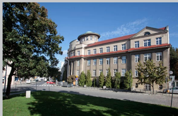
1. Herb na budynku administracji gazowni przy ul. Grobla 15
