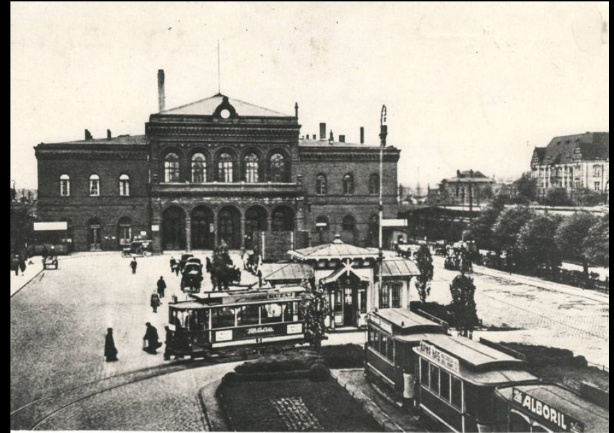
12. Dworzec Kolejowy przed wielką modernizacją (do 1929 roku) 35
