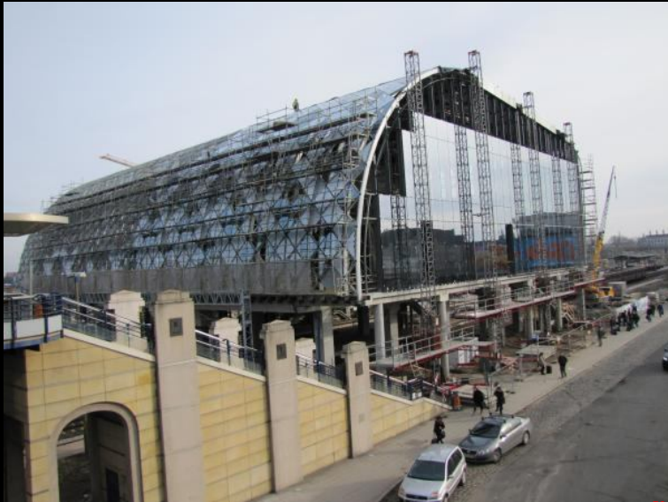
27. Budowa nowego dworca kolejowego w Poznaniu (widok z Mostu Dworcowego) 72
