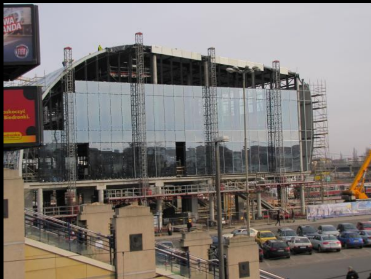
28. Nowy dworzec kolejowy w Poznaniu w stanie zaawansowanych prac 73
