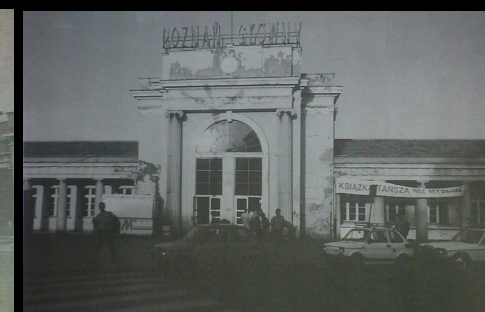
22. Dworzec Zachodni przed rewaloryzacją (1995 rok) 49
