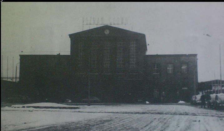
16. Wygląd Dworca Głównego przed modernizacją 42
